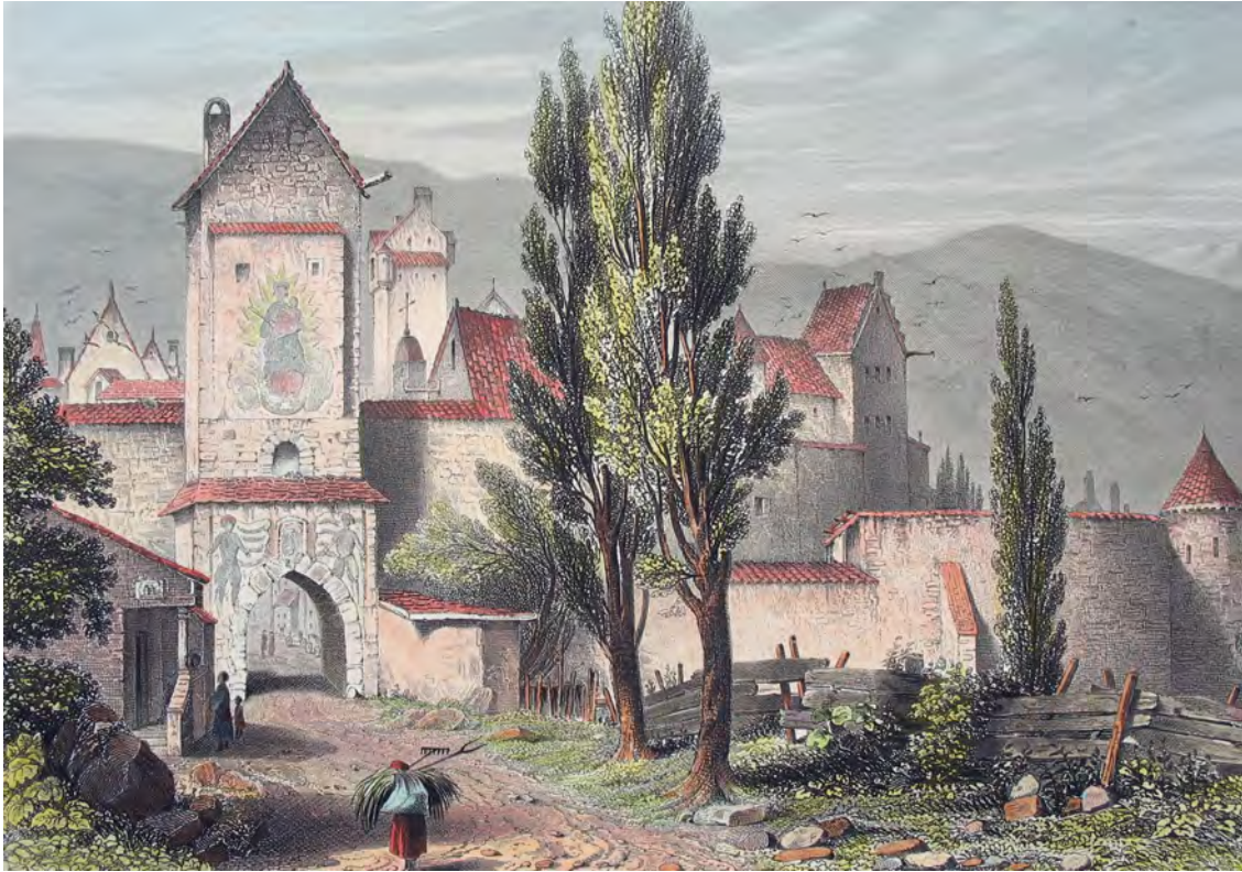
Abb. 1: Das Augsburger Tor mit Zollhäuschen (links) und dem Sonnenwirtsanwesen (rechts). Der Mauerturm rechts und der Turm im Hintergrund sind Fantasieprodukte.
