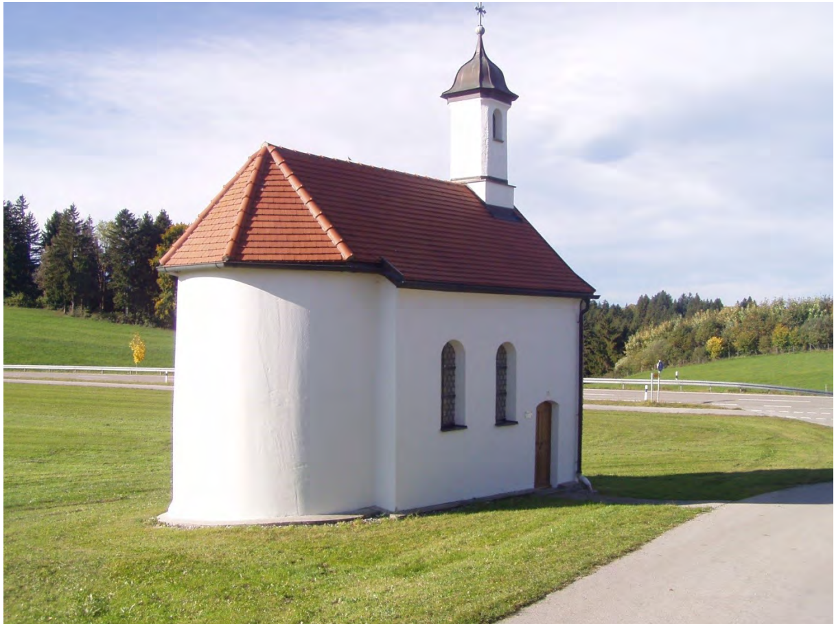
Die frisch renovierte Kapelle von Engelbolz mit Dachreiter und halbrundem Chor
