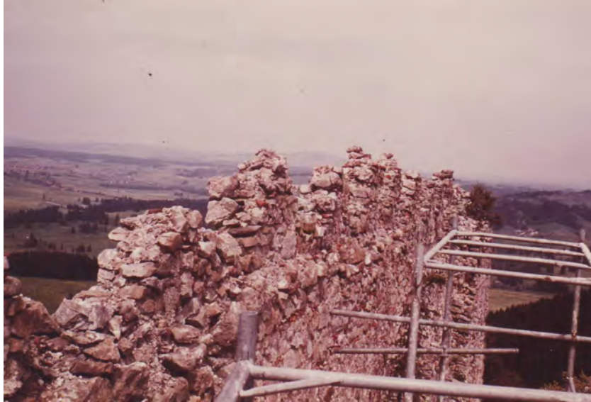
Abb. 10: Zinnen auf der Westmauer vor der Mauersanierung
