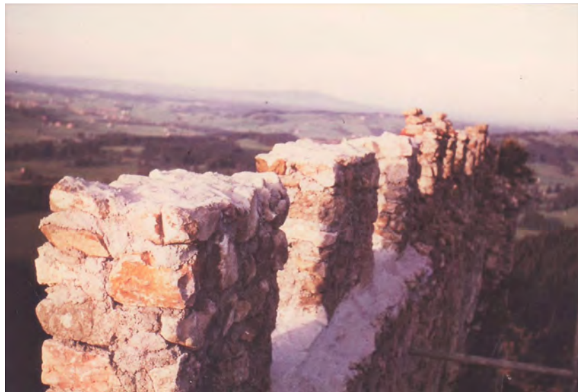
Abb. 11: Zinnen auf der Westmauer nach der Mauersanierung
