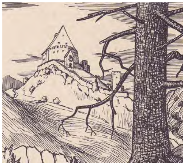
Abb. 8: Satteldach auf der Burg Eisenberg?
