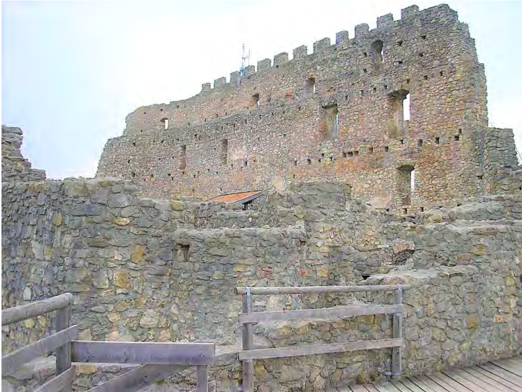
Abb. 17: Die Innenansicht der hohen Ringmauer nach den Erhaltungsmaßnahmen.
