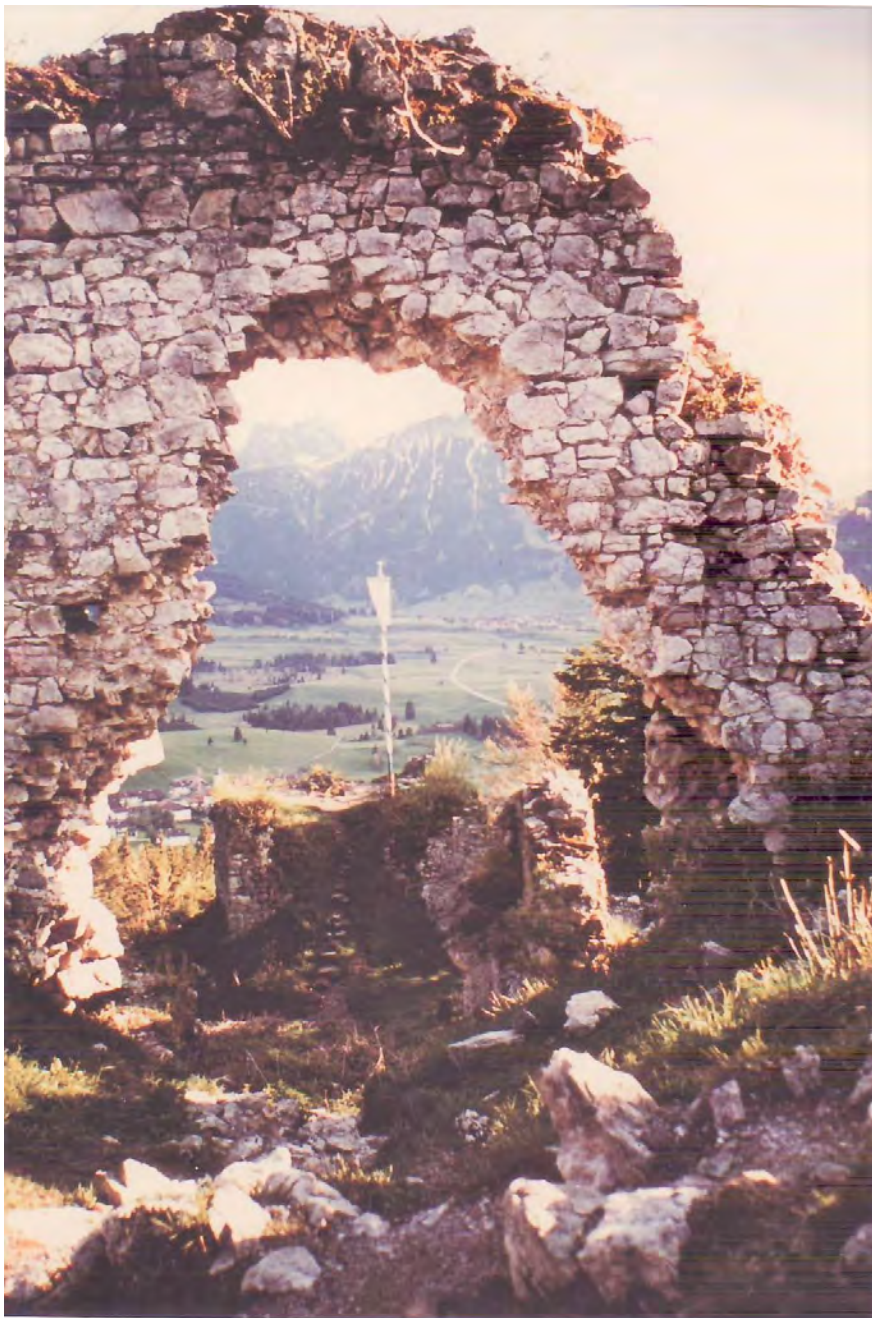
Abb. 1: Südliches Haupttor der Burg Eisenberg vor den Sanierungsmaßnahmen.
