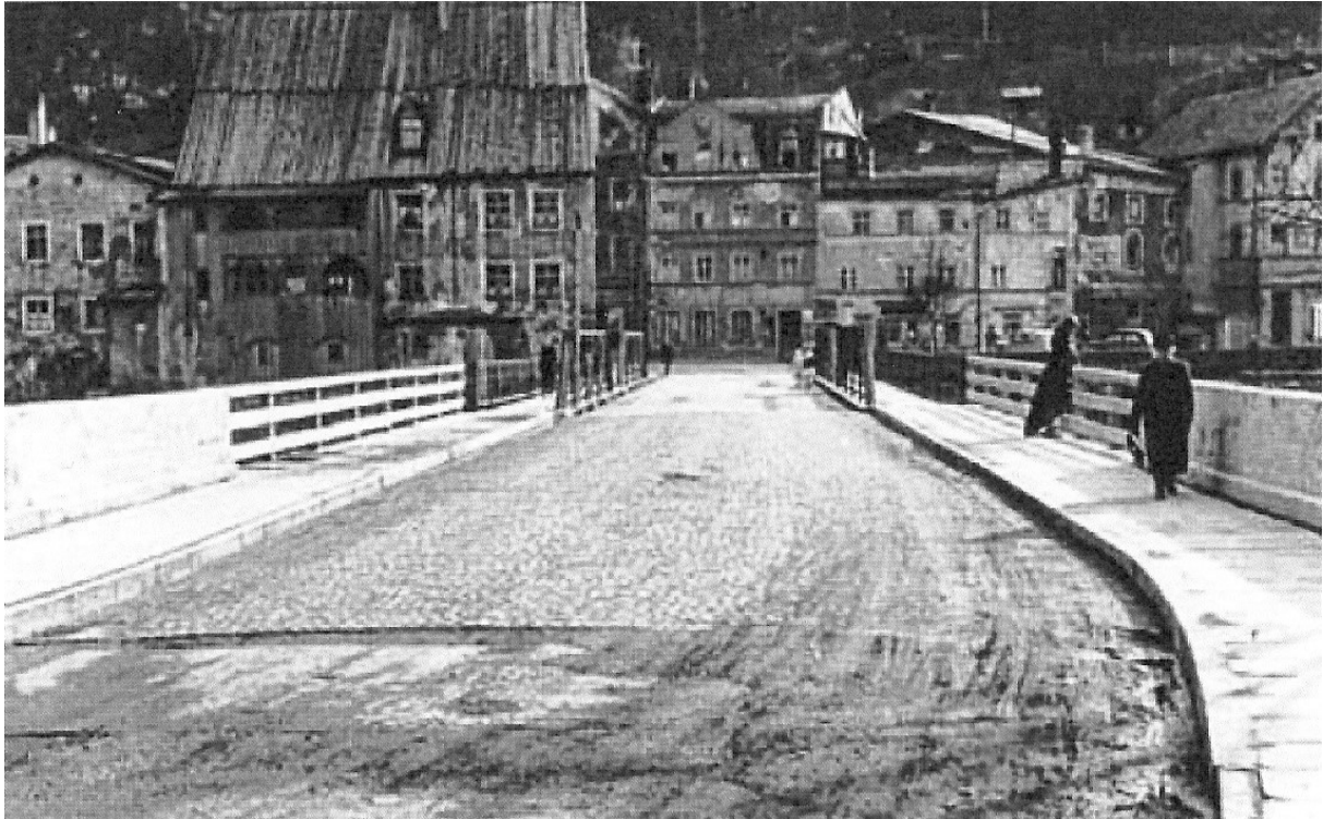
Abb. 1: An dem mit Brettern ausgebesserten Geländer im Vordergrund kann man erkennen, dass von der Stadt her gesehen der erste Brückenteil der Theresienbrücke gesprengt wurde, während im Hintergrund noch die Eisenteile der Brücke aufragen. Beim Eckhaus an der Schwangauer Straße (Schiffswirtschaft) sind die Dachplatten durch die Explosion zerstört worden, darum wurde das Dach mit Brettern abgedeckt.
