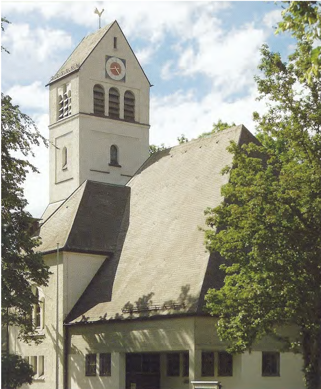
Abb. 3: Nach dem Abriss des hinteren Kirchenteils wurden Sichtbetonwände hochgezogen.
